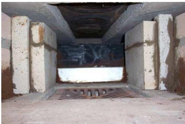
Uma vez que todas as partes - inclusive forno - estão aquecidas este processo é eficiente ao ponto de ao se deixar a tampa da chapa de cozimento aberta, a fumaça e vapor são sugados pelo buraco da chapa de ferro fundido.
