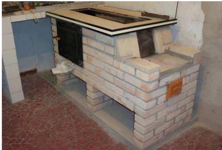
Para ter o forno nessa posição, abaixo da chapa, o calor e fumaça deveriam ser gerados na fornalha e circular em toda volta do forno de ferro fundido, até encontrar a saída para a chaminé.
